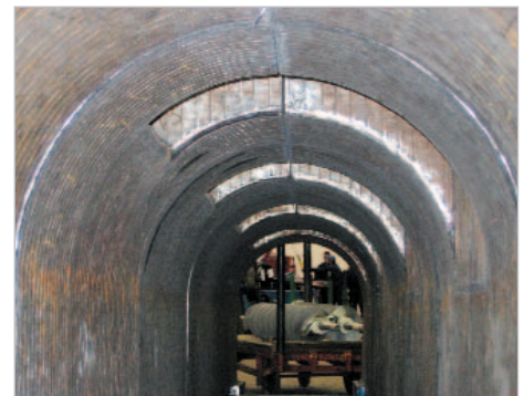
Revêtement intérieur d'une auge à écorce. Internal overlay of a bark conveyor housing.
